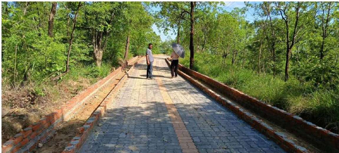
बोलबम सा.व.मा पिकनिक तथा जिमस्थल पहुँचमार्ग निर्माण
